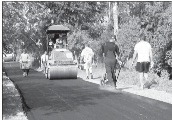
Работы по асфальтированию на улице Дружбе
