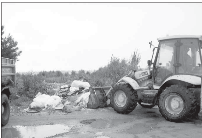
Ликвидация несанкционированной свалки мусора
